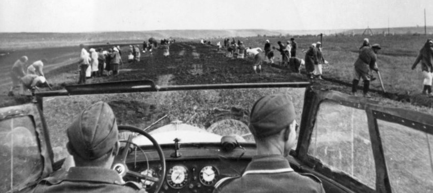
Жители Майкопа ремонтируют дорогу. 1942 год.
