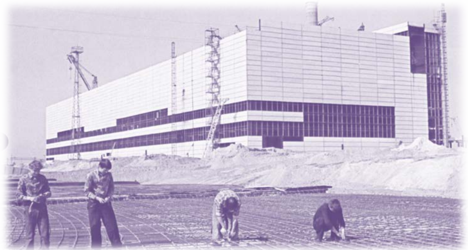
Строительство Чернобыльской атомной электростанции.
