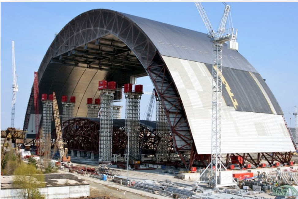
Строительство нового саркофага.
