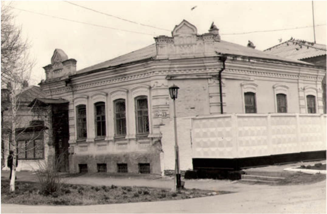
Здание милиции Гиагинского района
