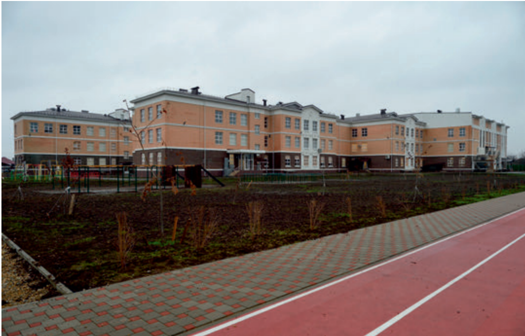
Здание школы № 2 на 1100 мест в поселке Энем
