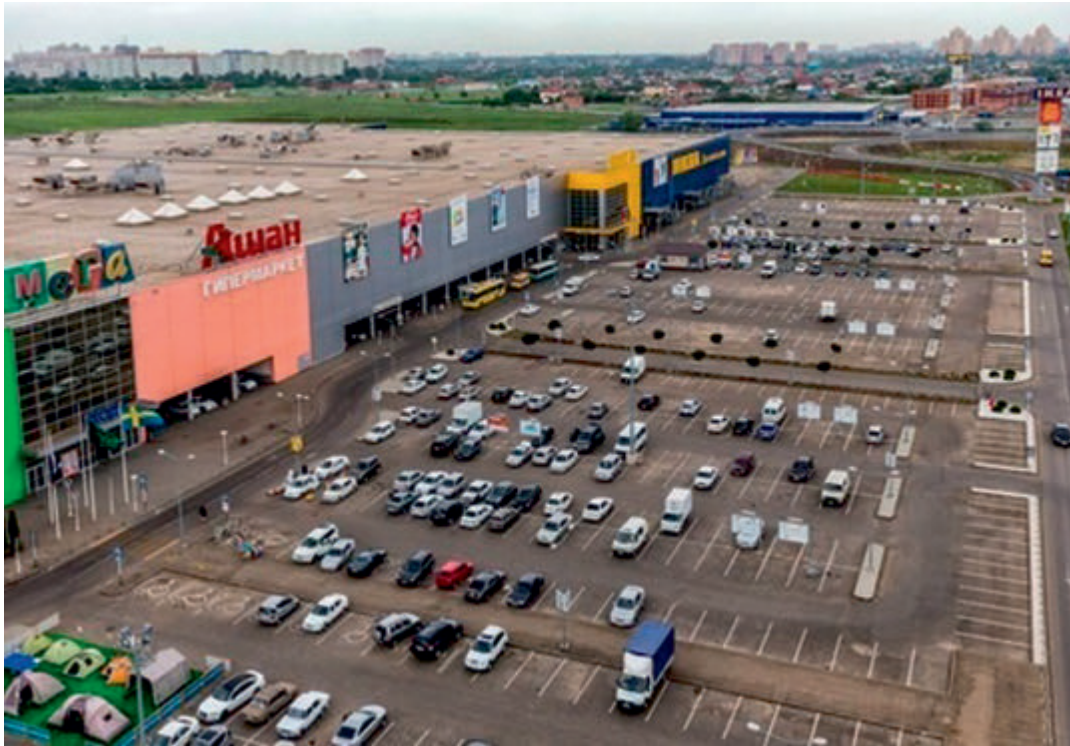
Площадка для транспорта у торгового комплекса
