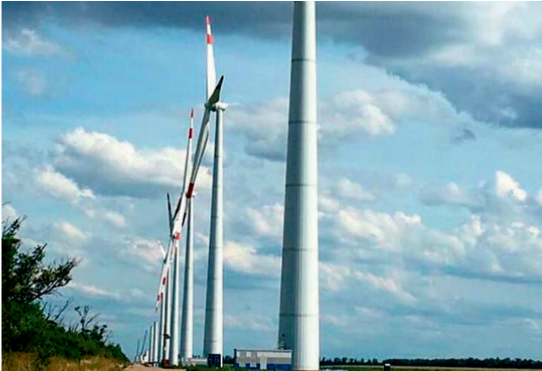
Адыгейская ветряная электростанция на границе Гиагинского и Шовгеновского районов
