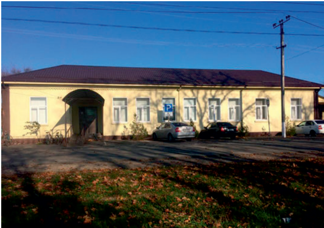
Врачебная амбулатория после ремонта 2018 г. в селе Натырбово
