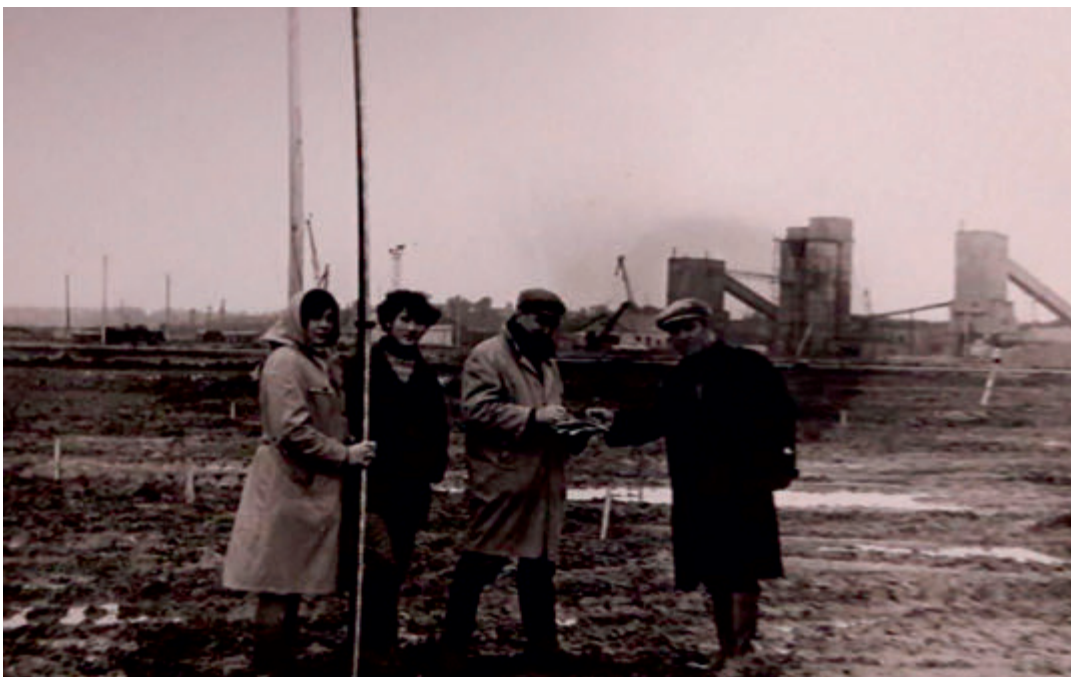
Строительство Краснодарского водохранилища, 1969 г.
