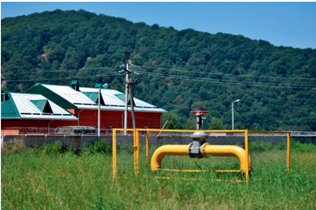
Строительство газопровода в Майкопском районе
