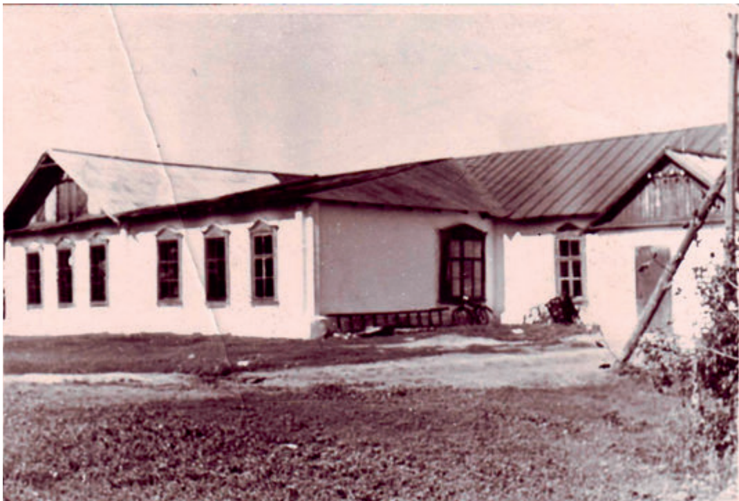
Старое здание школы
